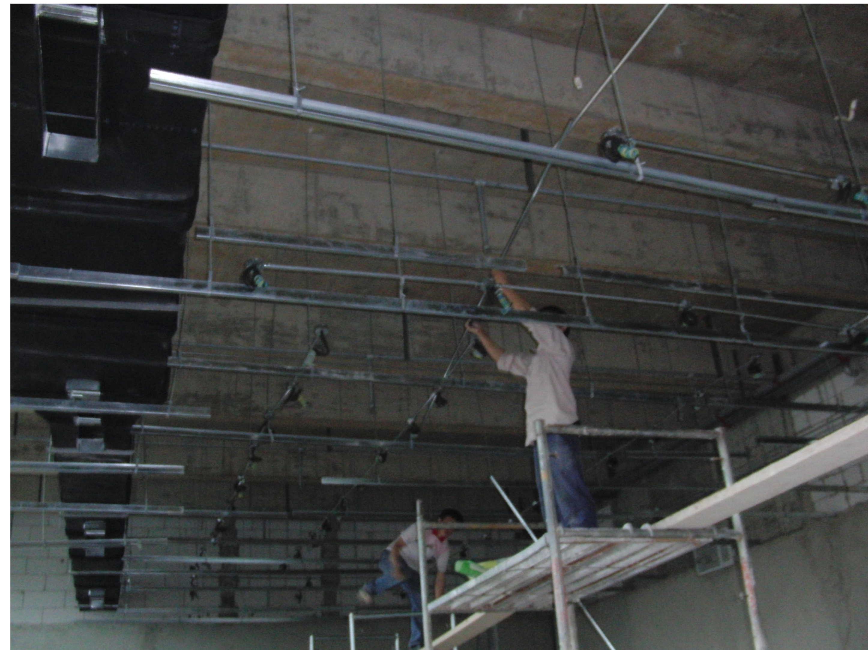
↑ 大厅电工排线
