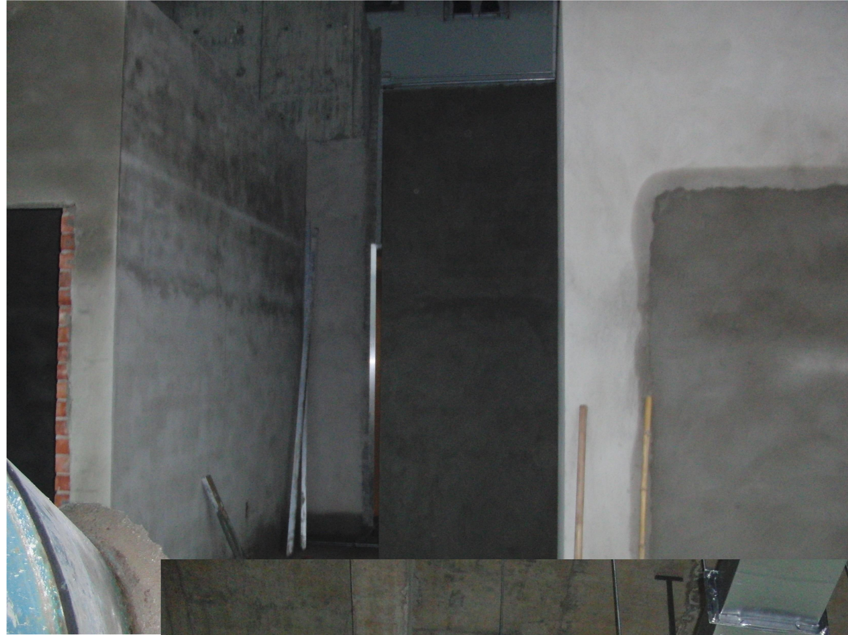
卫生间新砌隔墙
