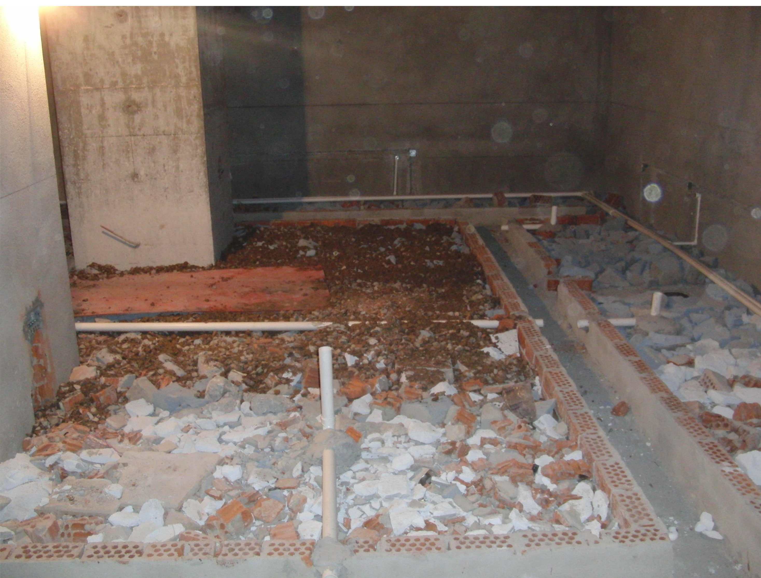
厨房地坪及水沟
